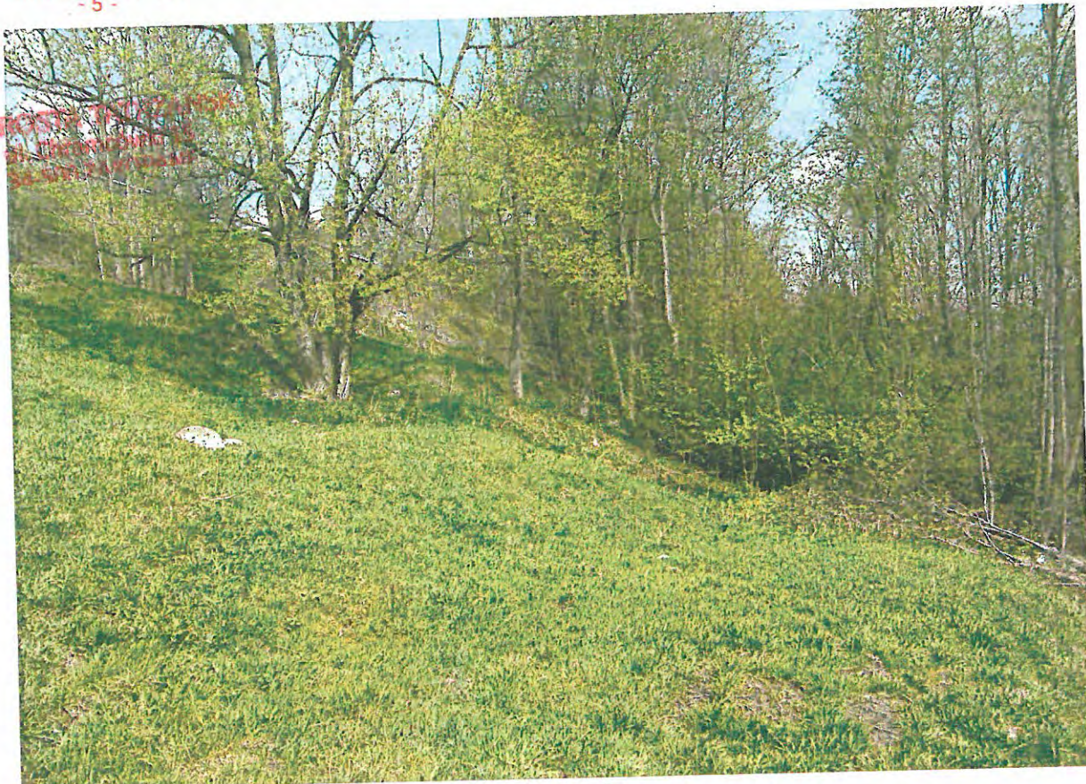
Fot. 8 – Widok na osuwisko od strony wschodniej.
