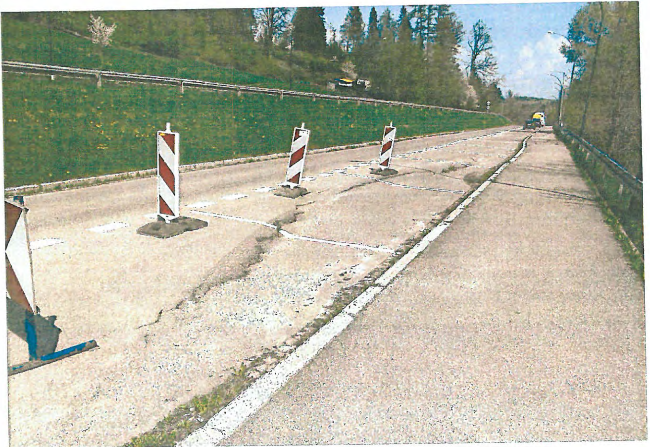
Fot. 5 – Spękania i deformacje w obrębie drogi powiatowej (skarpa główna).
