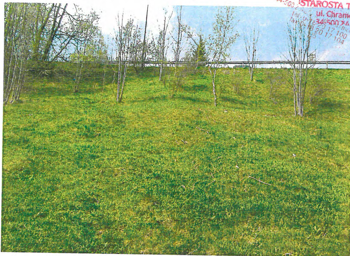
Fot. 6 – Widok na osuwisko od strony zachodniej.
